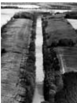
◀ Zwischen Klein-Königsförde und Kluvensiek hat der Kanal das Landschaftsbild entscheidend neu geprägt. In diesem Abschnitt wurde die Kanaltrasse, die sonst dem Verlauf der Eider folgte, neu gegraben und der Aushub seitlich als Randwall aufgeschichtet. Foto: Landesamt für Denkmalpflege, 1980
