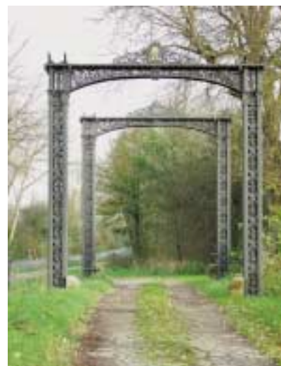
► Gusseiserne Brückenbögen der ehemaligen Klappbrücke von 1840/50 an der Schleuse Kluvensiek Foto: F. Schneider, 2001
