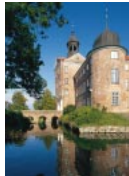
◄ Schlossgebäude und -brücke nach der Sanierung Das Wasserschloss der Eutiner Fürstbischöfe bildet das Zentrum der Gesamtanlage und beherbergt heute ein Museum. Foto: F. Schneider, 1998
