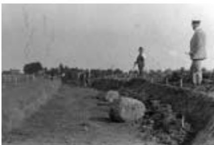
◀ Bodenmodellierung für die Anlage der Knickwälle am südlichen Weg der Pferdeweide Aufnahme von 1910/12 Archiv Kreisverwaltung Ostholstein
