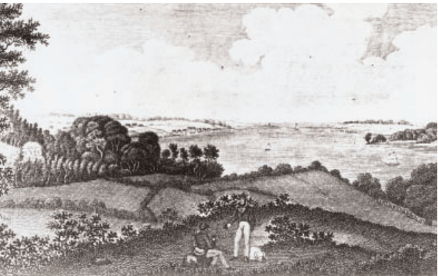
Blick auf das Gelände der Forstbaumschule an der Kieler Förde Links im Bild erkennt man das mit Hirschgeweihen verzierte kleine Unterrichtsgebäude für die Forsteleven. Kupferstich von Johann Ludwig Hansen d. Ä. um 1820 Stadtarchiv Kiel
