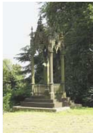
▲ Das von Christiania jun. für seinen Vater errichtete Grabmal (Grabkreuz unter Baldachin) wurde von der königlichen Eisengießerei in Berlin gefertigt. Unterhalb des Baldachins befindet sich die gemauerte Gruft, die über eine zweifläufige gusseiserne Treppe zu erreichen ist. Foto: F. Schneider, 1994
