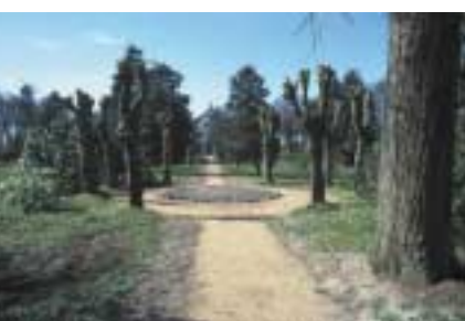
◀ Eines der drei Lindenrondelle auf der Hauptachse des Barockgartens. Das Foto zeigt die Sanierung des mittleren Rondells im Frühjahr 1997. Foto: Landesamt für Denkmalpflege
